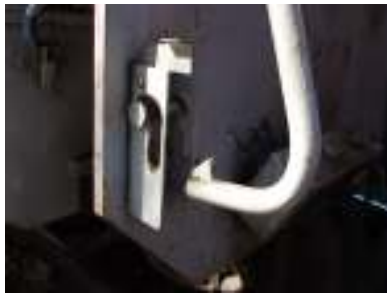
錠揚げ浮上り防止ストッパー取付状態(DL)
