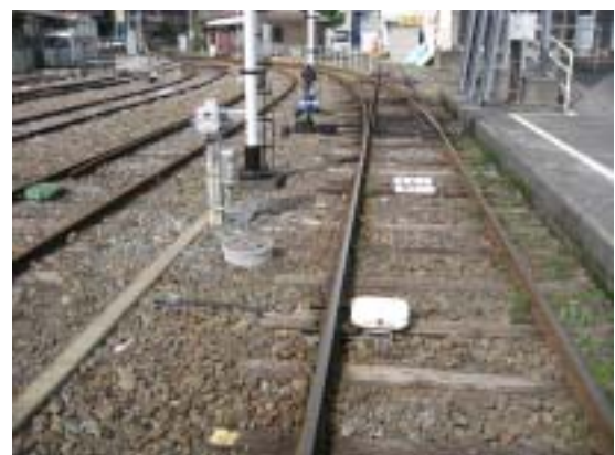
千頭駅構内の地上子設置状況(井川線)
