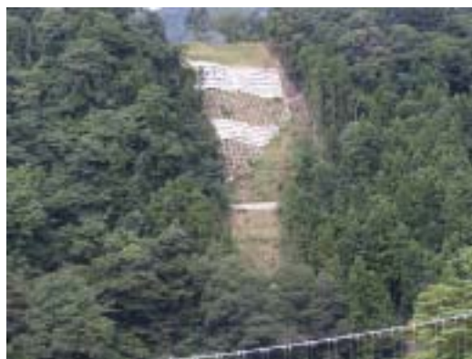
川根両国～沢間駅間 工事完了
