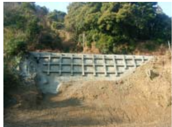
五和～神尾駅間(8k800M)工事完了
